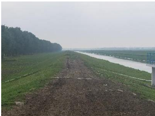
左岸堤顶路和边坡草皮护坡情况
